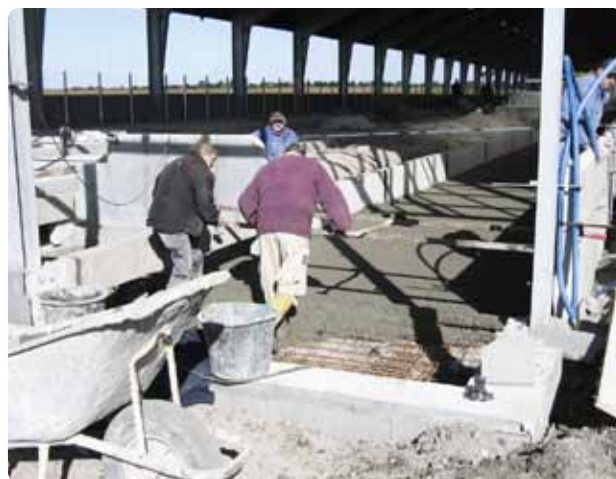
Figur 9.8 Det er vigtigt med et godt samarbejde mellem håndværkerne på byggepladsen.
