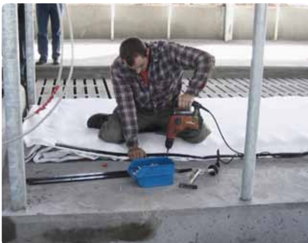
Figur 4.4 Montering af f.eks. madrasser kan være arbejde som bygherren og hans ansatte selv udfører.
