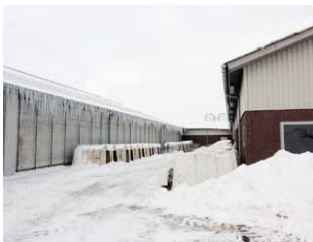
Figur 5.4 Vintervejr kan stoppe staldbyggeri i både uger og måneder.
